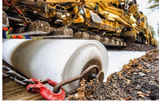
Bild 4: Anwendung Trennen im Eisenbahnbau (Quelle: Naue)
