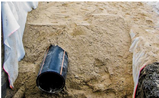
Bild 8: Filter in Entwässerungsanlage (Quelle: Naue)
