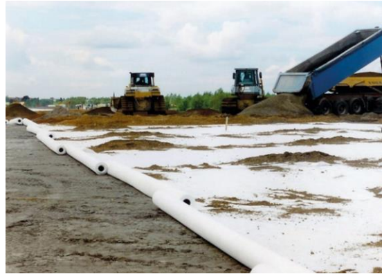
Bild 6: Trennen BAB A 38 (Quelle: Beco)
