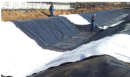
Bild 11: Schutz der Kunststoffdichtungsbahn in einem Kanalbauwerk (Quelle: Gepro Dresden)
