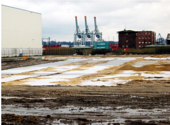
Bild 5: Anwendung Trennen für Containerabstellfläche (Quelle: TenCate)
