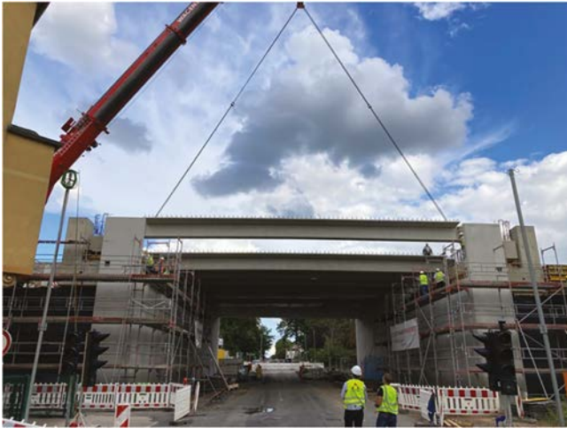
Bild 4 Widerlager der BAB A43 an der Hochlarmarkstraße aus KBE während des Einbaus der Fertigteilteile für den Überbau Abutment of the Hochlarmark Bridge along the Autobahn A43 made of KBE during the lifting of the semi-finished parts for the superstructure
