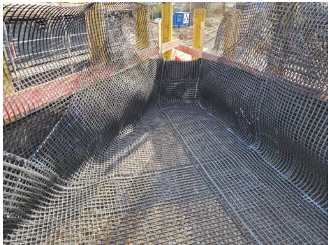
Bild 6 Bewehrungsführung im Bereich der spitzen Ecke der KBE-Widerlager der BAB A40 Reinforcement in the area of the sharp corner of the KBE-abutment of the Hafenbahn Bridge along the Autobahn A40
