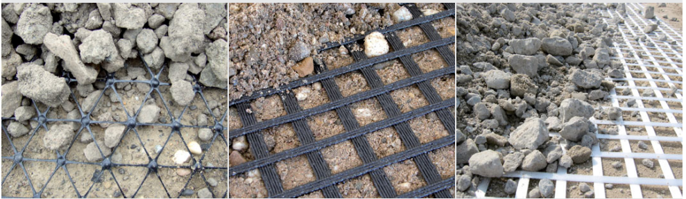
Abb. 6 Geogitter im Verbund zur Tragschicht
