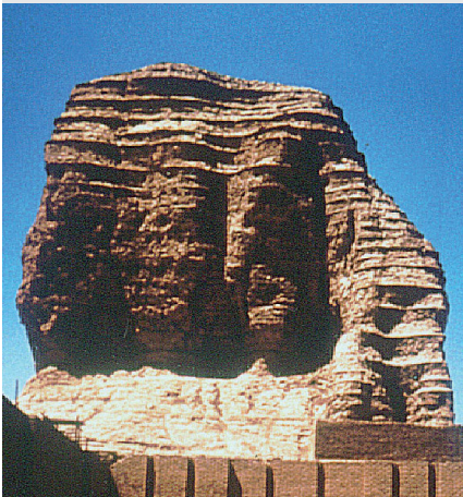
Abb. 2 Erdpyramide (Ziggurat Aqar Quf) im Irak mit Bewehrungslagen aus Papyrus
