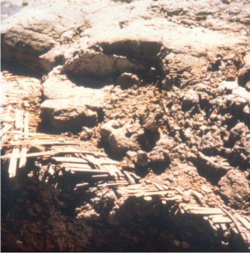
Abb. 3 Die „Urídee“ der Bewehrung von Böden in der Erdpyramide Ziggurat Aqar Quf
