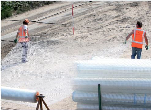
Abb. 11 Einfache Abrollvorrichtungen für den Geogitterzuschnitt auf der Baustelle
