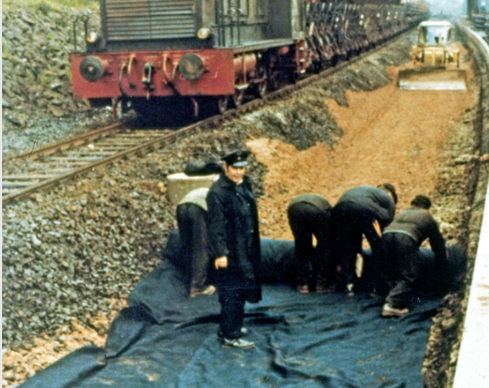
Abb. 4 Verlegung von Geokunststoff zur Stabilisierung der Bodengrenzschichten im Bahnbau, 1972
