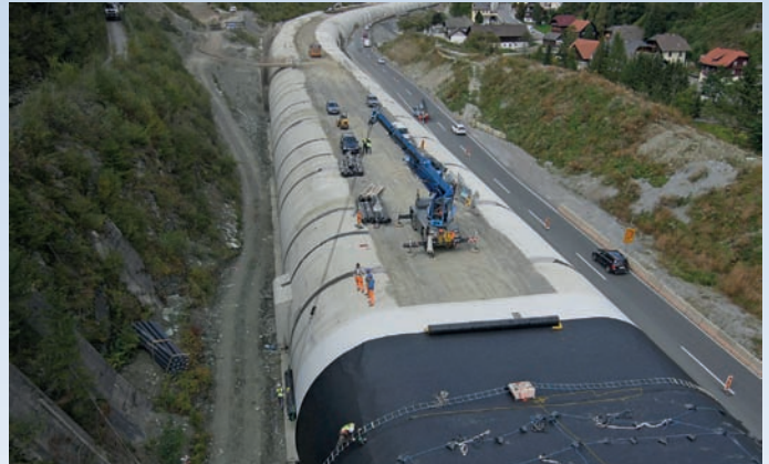
Bild 3: Beginn der Abdichtungsarbeiten
