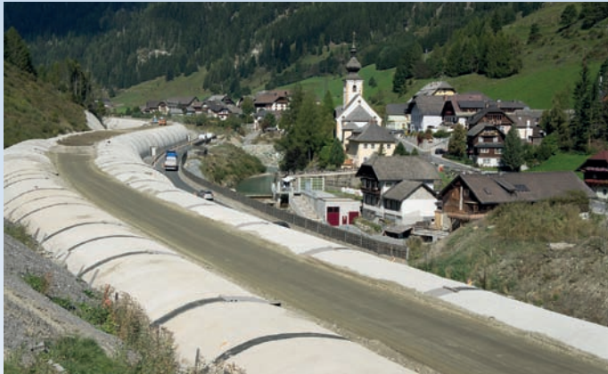
Bild 2: Trapezförmiger Spalt zwischen den Tunnelröhren. Auffüllen des trapezförmigen Spaltes mit Schüttmaterial
