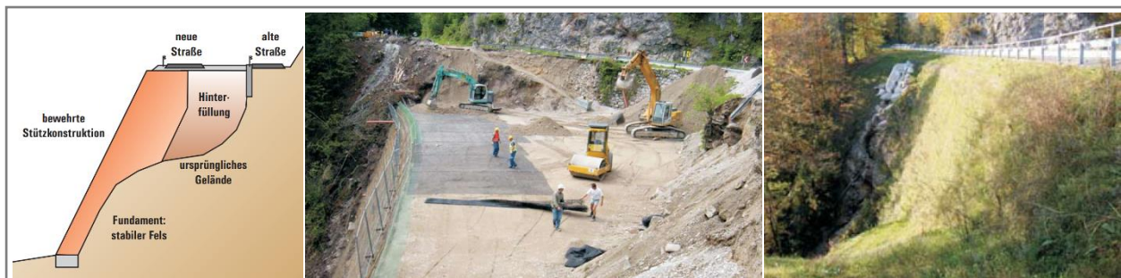
Abb. 2: Querschnitt (links), Ausführung (Mitte), Endzustand (rechts) ©TenCate Geosynthetics
