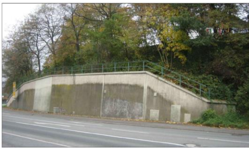
Klassisches Stahlbeton-Stützbauwerk Foto: Straßen.NRW
