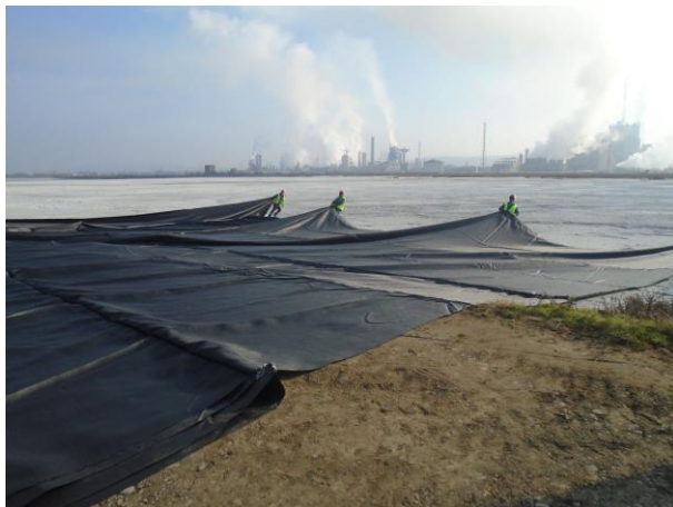
Bild 1: Beispiel für konfektionierte Gewebe (Quelle: Huesker)
