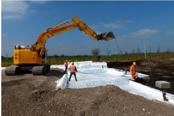
Bild 6: Gewebe Verlegung 2-lagig (Quelle: TenCate)
