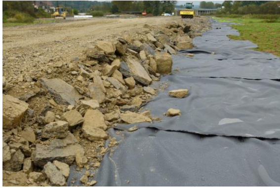
Bild 4: Gewebe unter Baustraße (Quelle: TenCate)
