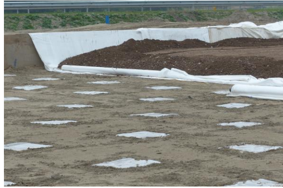
Bild 5: Gewebe zwischen Pfahlgründung und Damm (Quelle: TenCate)
